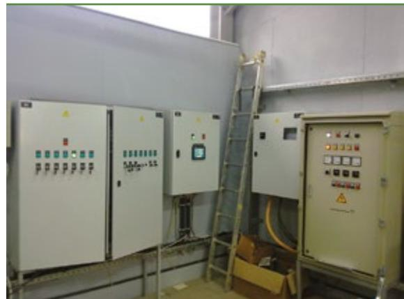
Все механическое оборудование для очистных сооружений, поставляемое компанией «Экопровод», может работать в автоматическом режиме и управляться локальными блоками с последующим выводом контрольной информации на центральный щит в диспетчерскую (операторскую). По желанию Заказчика при проектировании возможно предусмотреть как местное автоматическое, так и дистанционное управление электродвигателями насосных агрегатов, задвижек, воздуходувок и прочего оборудования.
