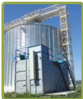
По конструктивному оформлению станции очистки хозяйствственно-бытовых и производственных сточных вод могут быть выполнены как в классическом (железобетонные или металлические емкости открытого типа), так и контейнерном (модульно-блочном) исполнении.
